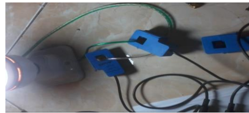
Gambar 29: Pengujian Dengan Kondisi Satu Sensor Arus Tidak Dikaitkan Pada Kabel
